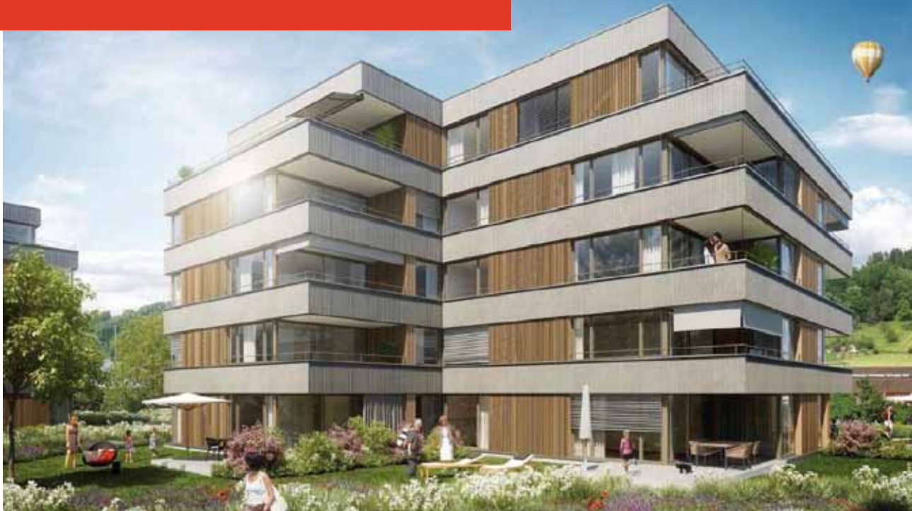
«Lindengarten» Gesamtüberbauung mit 8 Mehrfamilienhäusern, Dagmersellen
